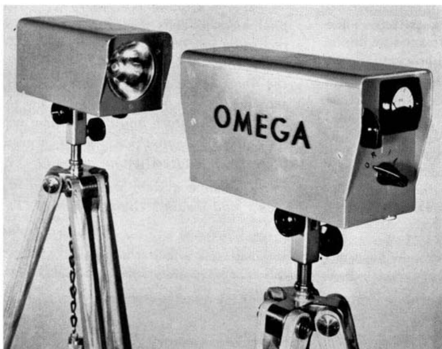
La cellula fotoelettrica per la registrazione degli arrivi nello sci.
