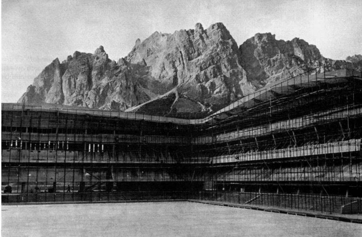
Lo stadio in avanzata costruzione, dominato dalle pareti frastagliate del Monte Pomagagnon preso a simbolo dei Giochi di Cortina.
